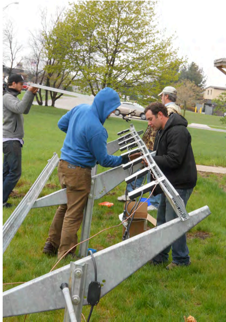
NWMC Enphase Install
