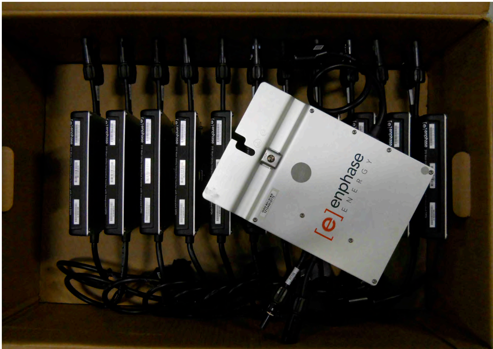
NWMC Enphase Install
